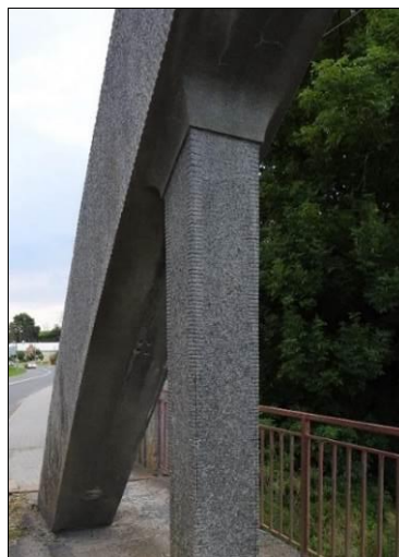
Obr. 78 Vlevo: klenbový most s estetickými prvky; Jihlava – most U Jánů, 1909, L = 16 m. Vpravo: esteticky ztvárněné podélné okraje oblouku a závěsů (vlysy) a esteticky ztvárněná hlavice v místě napojení závěsu na oblouk; Dřevohostice, 1931, L = 19,700 m
