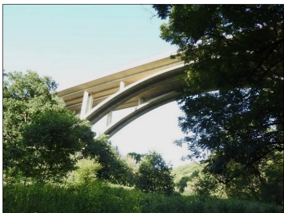
Obr. 23 Vlevo: oblouk s horní mostovkou – oblouk průřezu tvaru \pi ; Oparno, 2010, L = 135,0 m. Vpravo: oblouk s horní mostovkou – oblouk s komorovým průřezem (a rozděleným na dva pasy); Praha – Zbraslav, 1964, L = 86,000 m.
