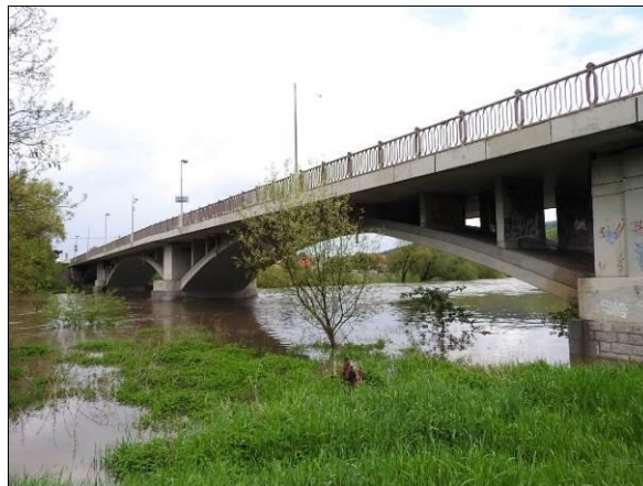
Obr. 81 Vlevo: oprava klenuté betonové konstrukce, původně trojkloubové – zesílení nabetonávkou klenby, zrušení kloubů a úprava na větknutou konstrukci; Peřimov, 1912, L = 45,000 m. Vpravo: oprava oblouku s horní mostovkou (původně konstrukce působila jako přesýpaná – klenutá) – na původních (zesílených) obloucích byla realizována nová mostovka se vzpěrami; Dobřichovice – Lety, realizace 1937, oprava 1999, L = 41,750 m.
