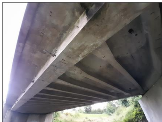
Obr. 64 Oblouk s dolní mostovkou uložený na ložiska a kyvné stojky, most s chodníky vně obloukových žebër. Vlevo: pohled na povrch mostu. Vpravo: podhled mostovky (podélná táhla/trámy, příčnky v místě závěsů a v polovině vzdálenosti mezi závěsy, vodorovné náběhy příčnky, mostková deska, konstrukce bez mezilehlých podélníků – ve své době ojedinělé řešení); Dřevohostice, 1931, L = 19,700 m, šířka 80,00 g.
