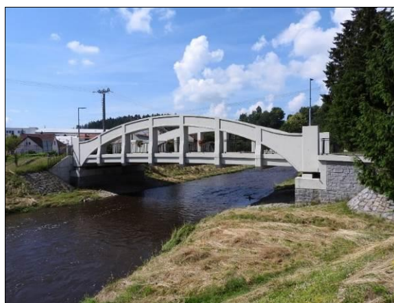
Obr. 85 Vlevo: replika obloukového mostu s horní mostovkou; Děčín – Litoměřická ulice, původní most 1914, replika 2000, L = 18,250 m. Vpravo: replika obloukového mostu s dolní mostovkou; Jimramov, původní most 1926, replika 2013, L = 21,000 m.
