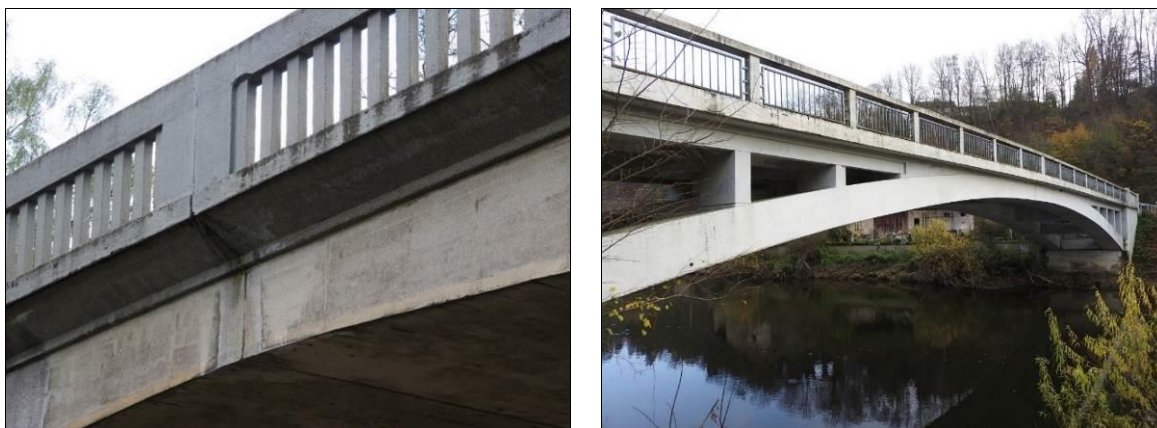
Obr. 28 Vlevo: klenbová trojkloubová konstrukce – detail betonového kloubu uprostřed rozpětí; Hradec u Stoda, 1928, L = 33,000 m (viz též Obr. 20 ).
