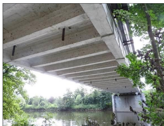
Obr. 65 Oblouk s dolní mostovkou, uložený na ložiskách, vozovka a chodníky mezi obloukovými žebry. Vlevo: pohled na povrch mostu a příčné ztužení nad vozovkou. Vpravo: podhled mostovky (podélná táhla/trámy, příčnky v místě závěsů a v polovině mezi závěsy, konstrukce bez podélníků, mostková deska – pod vozovkou i pod chodníky v jedné výškové úrovni); Brozany nad Ohří, 1953, L = 46,650 m.
