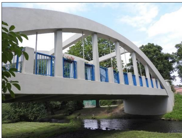
Obr. 82 Oprava oblouku s dolní mostovkou. Vlevo: zesílení svislých závěsů pomocí dodatečné svislé předpínací výztuže přímo u závěsů – pohled na kotvení nad závěsy; Zálužice, 1934, L = 42,500 m. Vpravo: doplnění dalších svislých závěsů z předpínací výztuže mezi původní železobetonové závěsy; Výrovice, 1924, L = 23,000 m.
