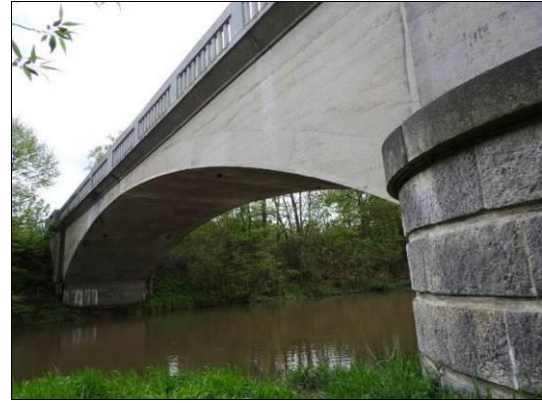
Obr. 20 Vlevo: klenbová konstrukce s volným nadnásypem (přesypávkou) – bez poprsních zdí; Sokolov (Lobezský potok), 1973, L = 11,000 m. Vpravo: klenbová konstrukce s poprsními zdmi; Hradec u Stoda, 1928, L = 33,000 m.
