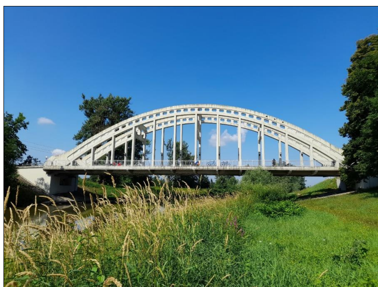
Obr. 25 Oblouk s dolní mostovkou s „prolamovanými“ obloukovými žebry; Darkov, 1925, L = 55,000 m
