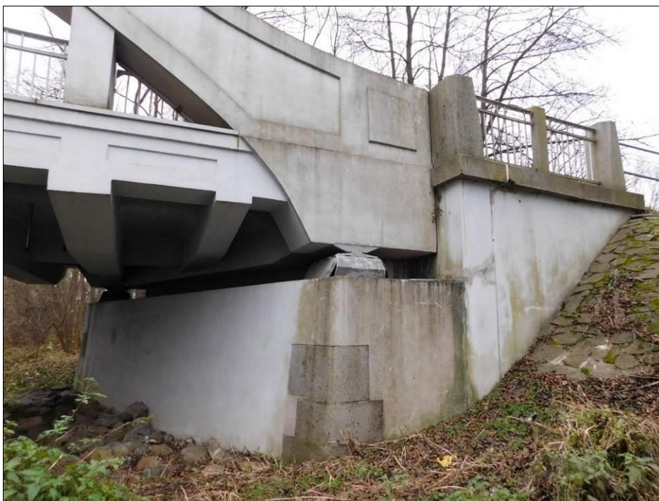
Obr. 69 Oblouk s dolní mostovkou uložený na ložiska – pohled mostovky v oblasti šikmého uložení na podpěru; Mirovice, 1933, L = 27,500 m, šikmost 76,67 g
