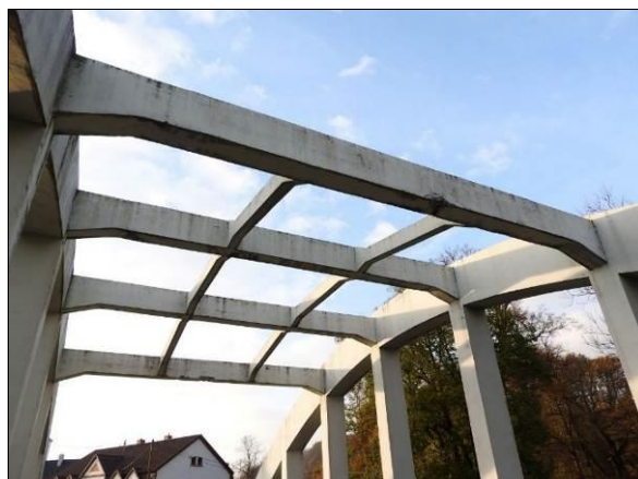
Obr. 52 Příčné ztužení mezi obloukovými žebry. Vlevo: šikmost mostu 100 g ( 90^\circ ); Besednice – Pořešín, 1913, L = 33,000 m. Vpravo: šikmost mostu 100 g; Bílý Kostel, 1925, L = 26,750 m.
