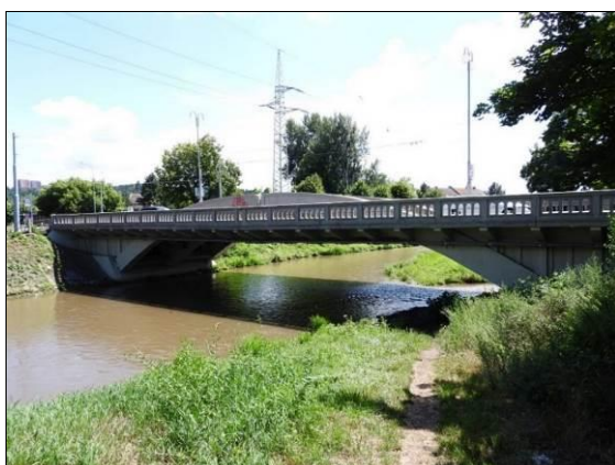
Obr. 43 Trojkloubový most s mezilehlou mostovkou. Vlevo: celkový pohled. Vpravo: pohled na povrch mostu. Brno, Husovice – Obřany, Jubilejní most, 1928, L = 33,000 m (viz též Obr. 44 ).
