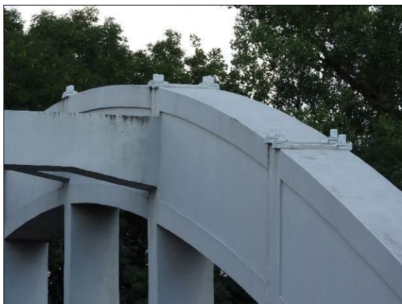
Obr. 82 Oprava oblouku s dolní mostovkou. Vlevo: zesílení svislých závěsů pomocí dodatečné svislé předpínací výztuže přímo u závěsů – pohled na kotvení nad závěsy; Zálužice, 1934, L = 42,500 m. Vpravo: doplnění dalších svislých závěsů z předpínací výztuže mezi původní železobetonové závěsy; Výrovice, 1924, L = 23,000 m.
