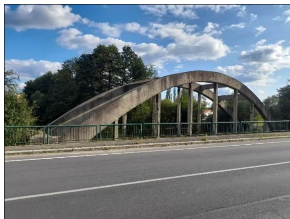
Obr. 84 Výstavba nového souběžného mostu, ponechání původního mostu pro lehkou dopravu. Vlevo: Smiřice, 1933, L = 33,000 m. Vpravo: Sokolov, 1920, L = 34,000 m.
