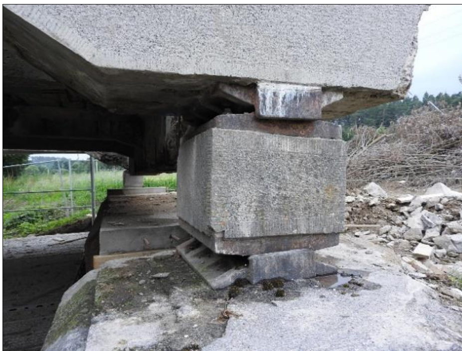
Obr. 40 Oblouk s dolní mostovkou, posuvné uložení pomocí železobetonových kyvných stojek s ocelovými klouby na horním a dolním konci; kyvné stojky představují méně časté řešení a měly by být zachovány (neměly by být při opravách nahrazovány novodobými ložisky); Bačkovice, 1929, L = 21,800 m
