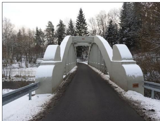
Obr. 77 Vlevo: esteticky ztvárněné ukončení mostu, vetknutý oblouk (mostovka rozdělená příčnou dilatační spárou u opěry); Uherský Ostroh, 1927, L = 52,80 m.
