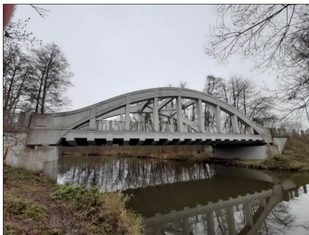
Obr. 62 Oblouk s dolní mostovkou, s chodníky, uložení na ložiska – celkový pohled; Mirovice, 1933, L = 27,500 m, šikmost 76,67 g
