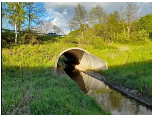
Obr. 72 Vlevo: směrově zakřivená komunikace na klenbové konstrukci – zakřiveno je zemní těleso (přesypávka), samotná klenbová konstrukce je kolmá; Nýřany, 1996, L = 7,650 m.
