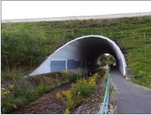
Obr. 20 Vlevo: klenbová konstrukce s volným nadnásypem (přesypávkou) – bez poprsních zdí; Sokolov (Lobezský potok), 1973, L = 11,000 m. Vpravo: klenbová konstrukce s poprsními zdmi; Hradec u Stoda, 1928, L = 33,000 m.
