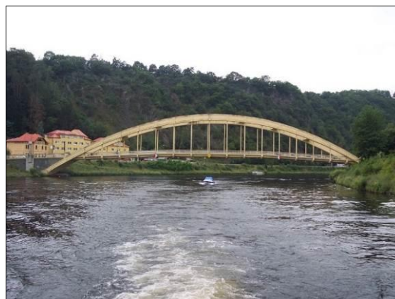
Obr. 24 Vlevo: oblouk s dolní mostovkou, uložený na ložiskách, oblouková žebra s plným obdélníkovým průřezem; Horní Vltavice, 1926, L = 27,300 m. Vpravo: oblouk s mezilehlou mostovkou, oblouková žebra vetknutá, s komorovým průřezem; výška průřezu oblouku se zmenšuje směrem k patkám z důvodu zmenšení ohybových momentů ve vetknutí do základů; Štěchovice, 1939, L = 113,800 m.
