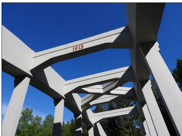
Obr. 52 Příčné ztužení mezi obloukovými žebry. Vlevo: šikmost mostu 100 g ( 90^\circ ); Besednice – Pořešín, 1913, L = 33,000 m. Vpravo: šikmost mostu 100 g; Bílý Kostel, 1925, L = 26,750 m.
