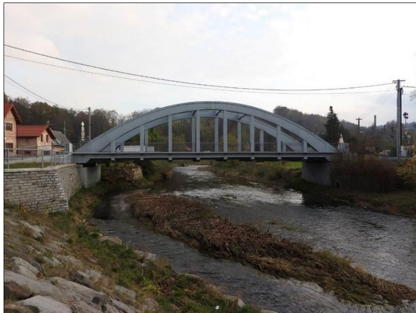
Obr. 37 Oblouk s dolní mostovkou, uložený na ložiskách – mostovka působí jako podélné táhlo; Chotyně, 1936, L = 28,100\text{ m}
