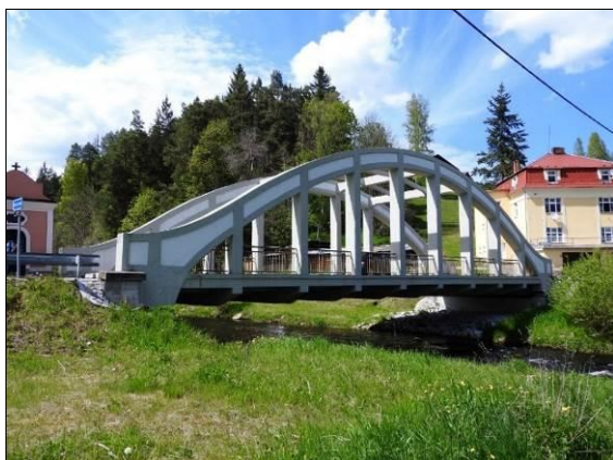
Obr. 24 Vlevo: oblouk s dolní mostovkou, uložený na ložiskách, oblouková žebra s plným obdélníkovým průřezem; Horní Vltavice, 1926, L = 27,300 m. Vpravo: oblouk s mezilehlou mostovkou, oblouková žebra vetknutá, s komorovým průřezem; výška průřezu oblouku se zmenšuje směrem k patkám z důvodu zmenšení ohybových momentů ve vetknutí do základů; Štěchovice, 1939, L = 113,800 m.
