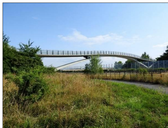
Obr. 76 Vlevo: oblouk s horní mostovkou a se vzpěrami mezi koncem mostovky a patkou oblouku; Klimkovice, 2009, L = 53,700 m.
