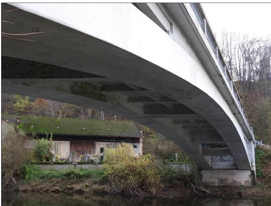
Obr. 68 Šikmý (trojkloubový) oblouk s horní mostovkou; Mohelnice nad Jizerou, 1930, L = 42,000 m, šikmost 75,33 g
