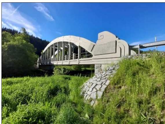
Obr. 42 Oblouk s dolní mostovkou – nosná konstrukce (oblouk i mostovka) vetknutá do obou podpěr, mostovka bez příčných dilatačních spár. Vlevo: celkový pohled. Vpravo: detail rámového rohu. Besednice – Pořešín, 1913, L = 33,000 m.
