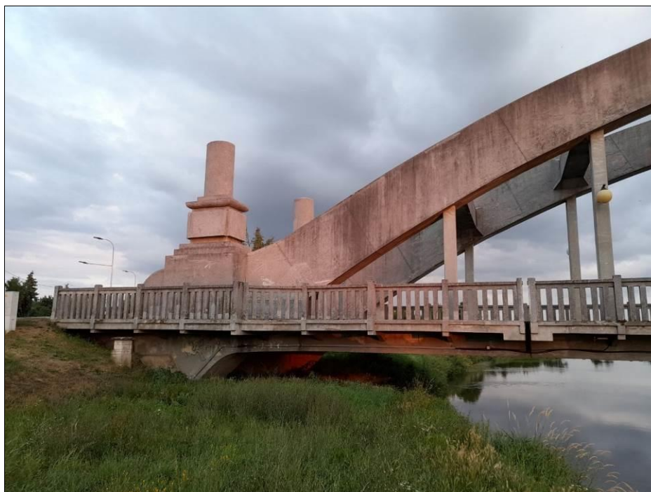
Obr. 46 Vetknutý oblouk s dolní mostovkou, mezilehlá příčná dilatační spára mostovky – u tohoto mostu je pouze u jedné opěry, u druhé podpěry příčná spára není; Uherský Ostroh, 1927, L = 52,800 m
