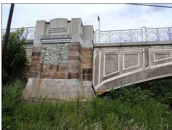
Obr. 27 Vlevo: klenbová trojkloubová konstrukce – kloub v patě klenby a svislá dilatační spára nad kloubem mezi pilířem a poprsní zdí nad klenbou; Postoloprty, 1909, L = 28,000 m.
