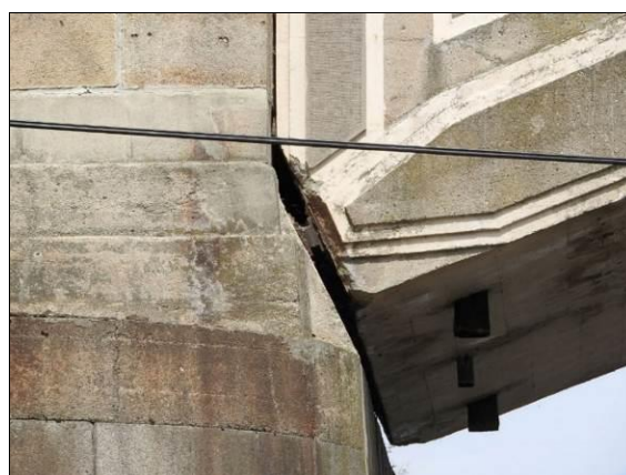
Obr. 27 Vlevo: klenbová trojkloubová konstrukce – kloub v patě klenby a svislá dilatační spára nad kloubem mezi pilířem a poprsní zdí nad klenbou; Postoloprty, 1909, L = 28,000 m.
