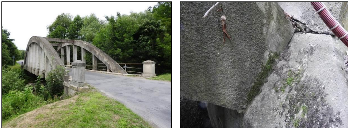
Obr. 45 Dvoukloubový oblouk s dolní mostovkou, mostovka je od opěry oddělena příčnou dilatační spárou. Vlevo: celkový pohled. Vpravo: detail kloubu v patě oblouku. Brantice, 1920, L = 32,000 m.
