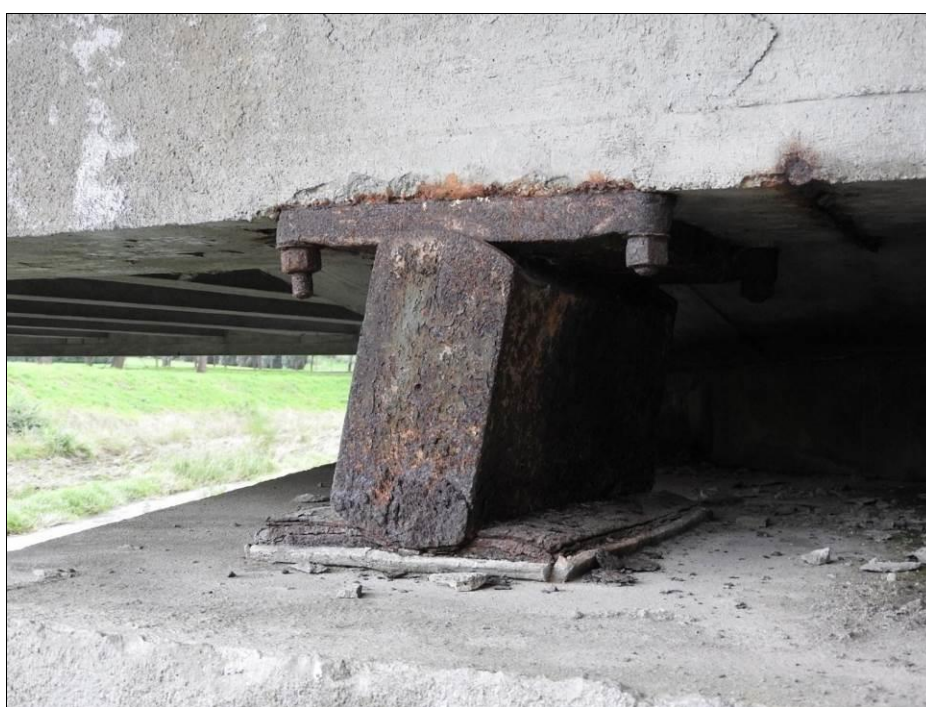
Obr. 41 Oblouk s dolní mostovkou, posuvné uložení pomocí ocelových kyvných stojek (ocelové kyvné stojky byly zjištěny pouze u tohoto mostu); Dřevohostice, 1931, L = 19,700 m
