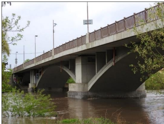
Obr. 21 Vlevo: oblouk s horní mostovkou – plný obdélníkový průřez oblouku; Dobřichovice – Lety, 1937, L = 41,750 m. Vpravo: oblouk s horní mostovkou – rozdělení oblouku na více obloukových pasů (zde je samostatná mostní konstrukce pro každý jízdní pás dálnice, každá mostní konstrukce má oblouk dále rozdělen na dva pasy); směrové zakřivení převáděné komunikace pomocí proměnného vyložení konzol; Píšť, 1941, L = 92,500 m
