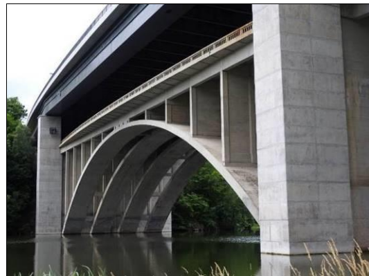
Obr. 21 Vlevo: oblouk s horní mostovkou – plný obdélníkový průřez oblouku; Dobřichovice – Lety, 1937, L = 41,750 m. Vpravo: oblouk s horní mostovkou – rozdělení oblouku na více obloukových pasů (zde je samostatná mostní konstrukce pro každý jízdní pás dálnice, každá mostní konstrukce má oblouk dále rozdělen na dva pasy); směrové zakřivení převáděné komunikace pomocí proměnného vyložení konzol; Píšť, 1941, L = 92,500 m
