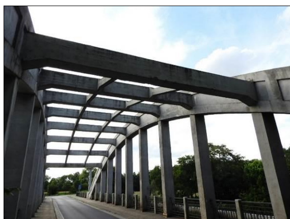
Obr. 65 Oblouk s dolní mostovkou, uložený na ložiskách, vozovka a chodníky mezi obloukovými žebry. Vlevo: pohled na povrch mostu a příčné ztužení nad vozovkou. Vpravo: podhled mostovky (podélná táhla/trámy, příčnky v místě závěsů a v polovině mezi závěsy, konstrukce bez podélníků, mostková deska – pod vozovkou i pod chodníky v jedné výškové úrovni); Brozany nad Ohří, 1953, L = 46,650 m.
