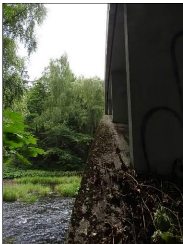
Obr. 74 Směrově zakřivená komunikace na oblouku s horní mostovkou. Vlevo: proměnná poloha vepřer na oblouku podél vnějšího okraje zakřivené komunikace. Vpravo: zakřivení oblouku podél vnitřního okraje zakřivené komunikace; Kružberk, 1960, L = 40,250 m (celkový pohled na most – viz Obr. 73 ).
