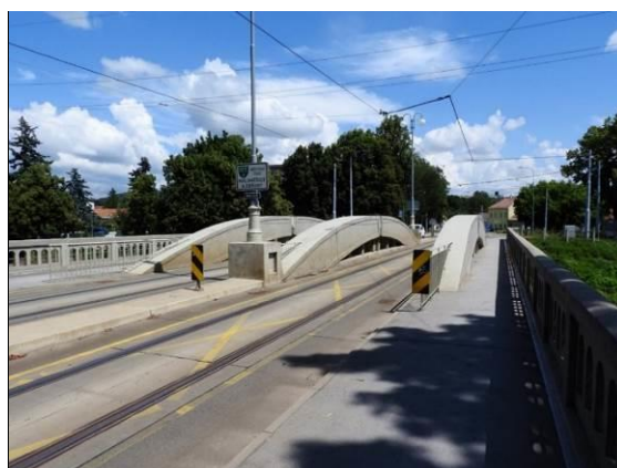
Obr. 43 Trojkloubový most s mezilehlou mostovkou. Vlevo: celkový pohled. Vpravo: pohled na povrch mostu. Brno, Husovice – Obřany, Jubilejní most, 1928, L = 33,000 m (viz též Obr. 44 ).
