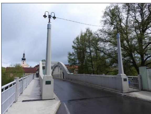
Obr. 66 Oblouk s dolní mostovkou, uložení na ložiska, chodníky vně oblouků. Vlevo: pohled na povrch mostu. Vpravo: podhled mostovky (podélná táhla v ose oblouků, mezilehlé podélníky, příčnky v místě závěsů, mostková deska vyvýšená v místě chodníků); Staňkov, 1920, L = 33,600 m.
