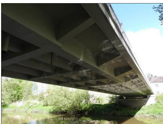
Obr. 66 Oblouk s dolní mostovkou, uložení na ložiska, chodníky vně oblouků. Vlevo: pohled na povrch mostu. Vpravo: podhled mostovky (podélná táhla v ose oblouků, mezilehlé podélníky, příčnky v místě závěsů, mostková deska vyvýšená v místě chodníků); Staňkov, 1920, L = 33,600 m.
