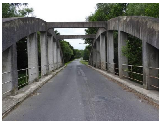
Obr. 59 Dvoukloubový oblouk s dolní mostovkou, bez chodníků. Vlevo: pohled na povrch mostu. Vpravo: pohled mostu – mostovka bez podélných táhel (vodorovná síla z oblouku se přenáší přímo do podpěr); Brantice, 1920, L = 32,000 m
