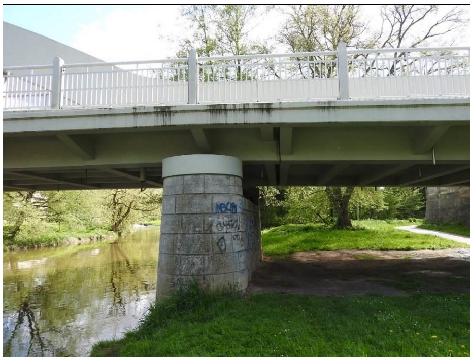
Obr. 51 Příklad zvláštního způsobu uložení u konstrukcí o více polích – trémová krajní pole jsou uložena na ozubu krátké konzoly vyložené z obloukové nosné konstrukce hlavního pole, pohled zdola; Staňkov, 1920, L = 33,660 m (viz též Obr. 50 )
