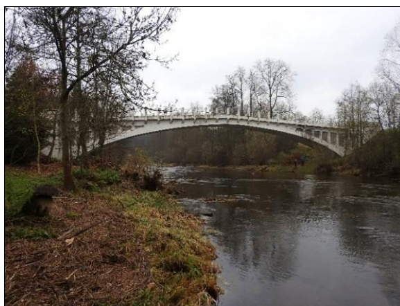
Obr. 19 Klenbový most u obcí Peřimov – Dolní Sytová, 1912 (vlevo: během výstavby [41], vpravo: v současnosti)
