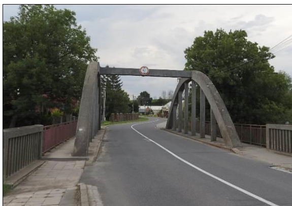
Obr. 64 Oblouk s dolní mostovkou uložený na ložiska a kyvné stojky, most s chodníky vně obloukových žebër. Vlevo: pohled na povrch mostu. Vpravo: podhled mostovky (podélná táhla/trámy, příčnky v místě závěsů a v polovině vzdálenosti mezi závěsy, vodorovné náběhy příčnky, mostková deska, konstrukce bez mezilehlých podélníků – ve své době ojedinělé řešení); Dřevohostice, 1931, L = 19,700 m, šířka 80,00 g.
