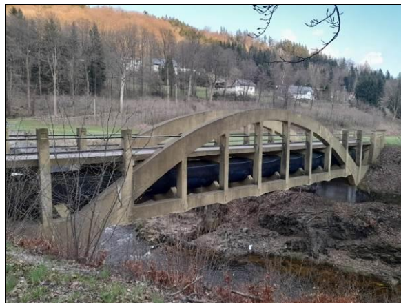
Obr. 75 Vlevo: náhrada části vzpěr nad obloukem menšími oblouky; Podolsko, 1942, L_{max} = 150,000 m. Vpravo: „dvoupatrová“ konstrukce s dolní a s mezilehlou mostovkou současně. Na horní mostovce je pozemní komunikace, na dolní mostovce je potrubí s přívodním kanálem do vodní elektrárny; MVE Popelnice – Tanvald, 1913, L = cca 30 m.
