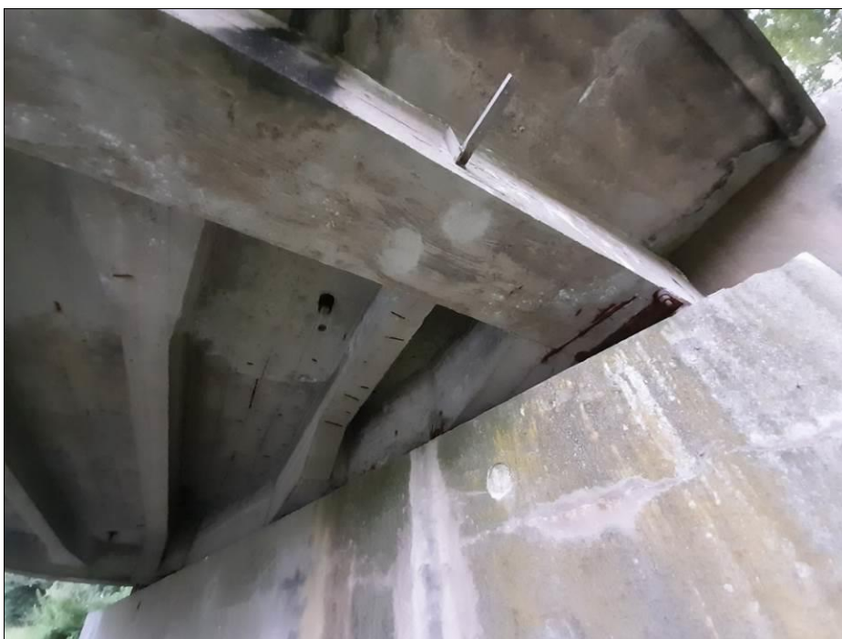
Obr. 70 Oblouk s dolní mostovkou uložený na ložiska – pohled mostovky v oblasti šikmého uložení na podpěru; Dřevohostice, 1931, L = 19,700 m, šikmost 80,00 g
