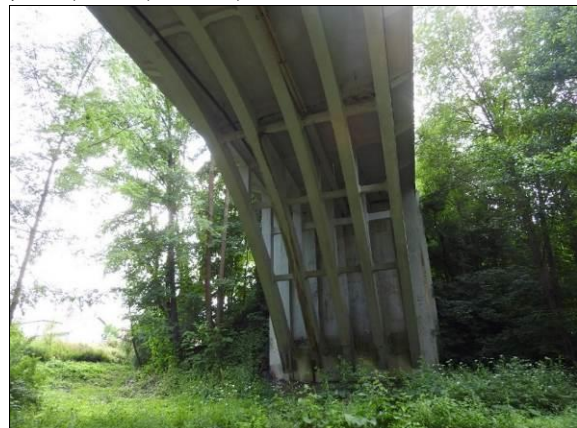
Obr. 22 Vlevo: oblouk s horní mostovkou – oblouk rozdělen na dvě žebra; Bechyně, 1928, L = 90,000 m.
