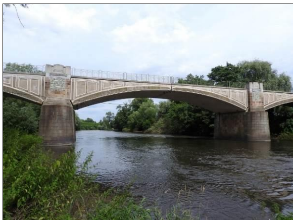
Obr. 26 Vlevo: klenbová trojkloubová konstrukce – celkový pohled na mostní pole nad řekou; Postoloprty, 1909, L = 28,000 m.
