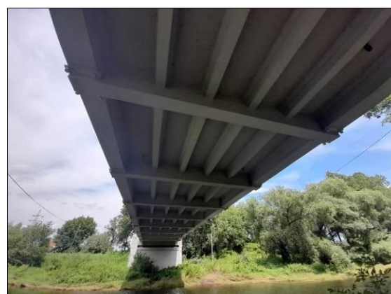
Obr. 60 Oblouk s dolní mostovkou, uložení na ložiska, bez chodníků. Vlevo: pohled na povrch mostu. Vpravo: pohled mostovky (podélná krajní táhla/trámy, mezilehlé podélníky, příčnický v místě závěsů, mostovková deska v jedné úrovni – most bez chodníků). Zálužice, 1934, L = 42,500 m.
