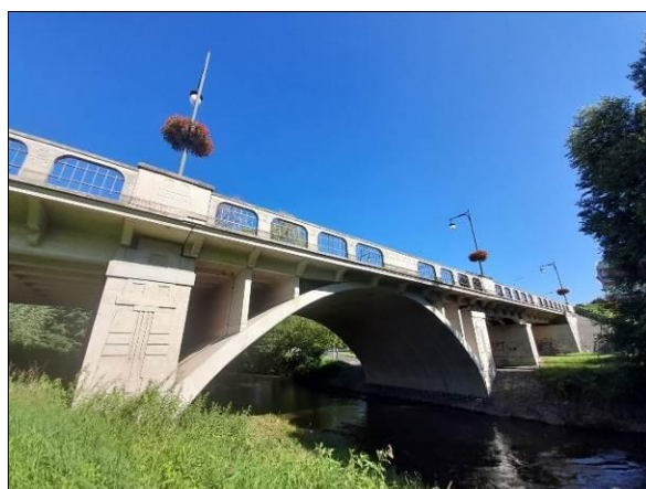
Obr. 85 Vlevo: replika obloukového mostu s horní mostovkou; Děčín – Litoměřická ulice, původní most 1914, replika 2000, L = 18,250 m. Vpravo: replika obloukového mostu s dolní mostovkou; Jimramov, původní most 1926, replika 2013, L = 21,000 m.
