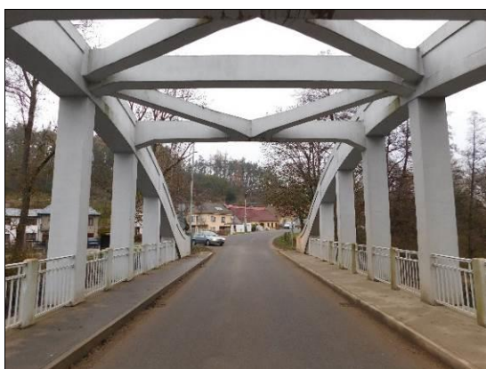
Obr. 63 Oblouk s dolní mostovkou, s chodníky, uložení na ložiska. Vlevo: pohled na povrch mostu. Vpravo: podhled mostovky – krajní táhla/trámy, příčnky v místě závěsů a v polovině vzdáleností mezi nimi, pouze jeden mezilehlý podélník, mostovková deska výškově odstupňovaná (zvýšená) v místě chodníků; Mirovice, 1933, L = 27,500 m, šikmost 76,67 g.
