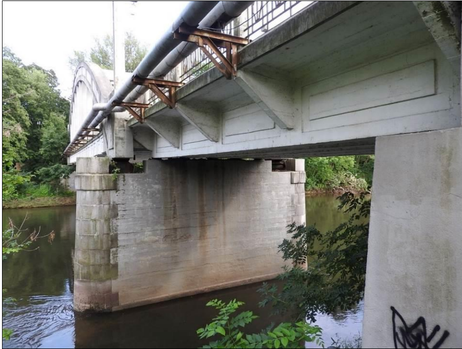
Obr. 49 Příklad zvláštního způsobu uložení u konstrukcí o více polích – „mimoběžné“ uspořádání ložisek nosné konstrukce v hlavním poli a ve vedlejším poli, ložiska z obou polí pak mohou být umístěna na jedné úložné přímce; Doksany – Brozany nad Ohří, 1953, L = 47,650 m
