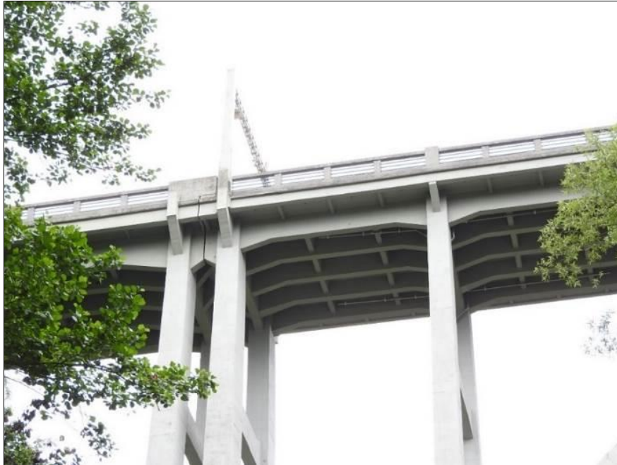
Obr. 29 Rošťová železobetonová mostovka oblouku s horní mostovkou; mostovka je zde rámově spojena se vzpěrami, vzpěry jsou členěné; na obrázku je rovněž příčná dilatační spára s mostním závěrem v mostovce nad patkou oblouku; Bechyně, 1928, L = 90,000 m
