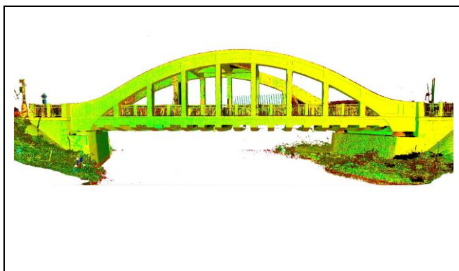
Obr. 14 Porovnání výsledků 3D statického skenování (tzv. mračna bodů - vlevo) a fotografie skutečného mostu (vpravo); Mirovice, 1933, L = 27,500\text{ m}
