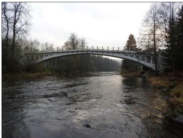
Obr. 81 Vlevo: oprava klenuté betonové konstrukce, původně trojkloubové – zesílení nabetonávkou klenby, zrušení kloubů a úprava na větknutou konstrukci; Peřimov, 1912, L = 45,000 m. Vpravo: oprava oblouku s horní mostovkou (původně konstrukce působila jako přesýpaná – klenutá) – na původních (zesílených) obloucích byla realizována nová mostovka se vzpěrami; Dobřichovice – Lety, realizace 1937, oprava 1999, L = 41,750 m.
