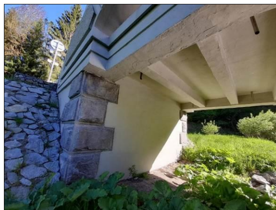
Obr. 42 Oblouk s dolní mostovkou – nosná konstrukce (oblouk i mostovka) vetknutá do obou podpěr, mostovka bez příčných dilatačních spár. Vlevo: celkový pohled. Vpravo: detail rámového rohu. Besednice – Pořešín, 1913, L = 33,000 m.
