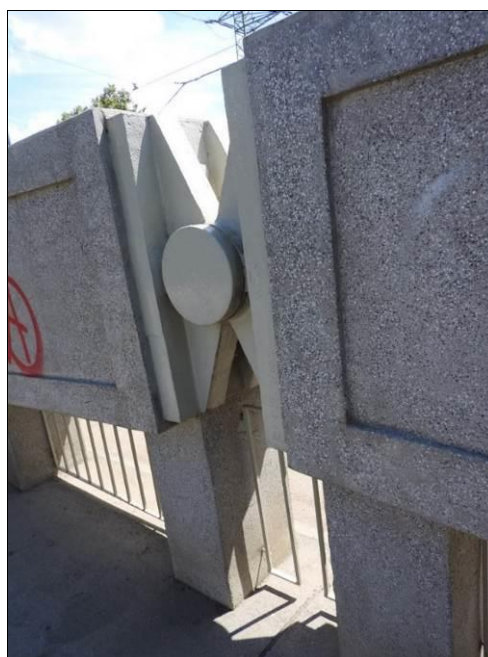
Obr. 44 Trojkloubový most s mezilehlou mostovkou – Brno, Husovice – Obřany, Jubilejní most, detail kloubu uprostřed rozpětí; 1928, L = 33,000 m (viz též Obr. 43 ).
