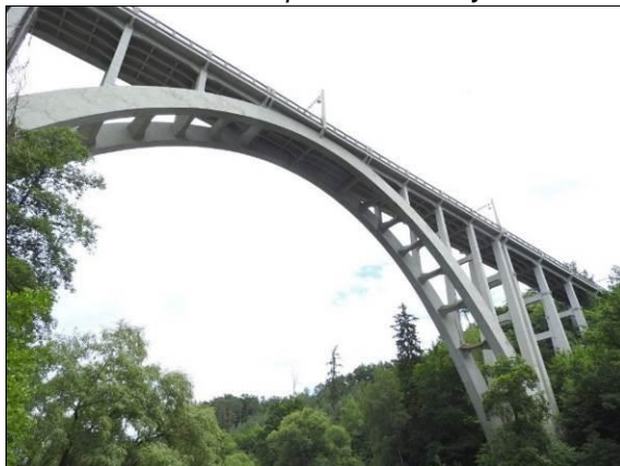
Obr. 22 Vlevo: oblouk s horní mostovkou – oblouk rozdělen na dvě žebra; Bechyně, 1928, L = 90,000 m.
