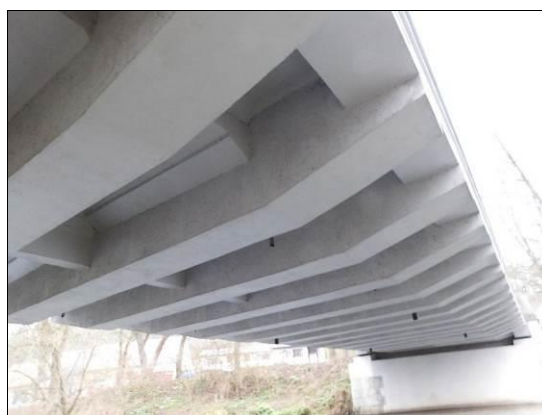
Obr. 63 Oblouk s dolní mostovkou, s chodníky, uložení na ložiska. Vlevo: pohled na povrch mostu. Vpravo: podhled mostovky – krajní táhla/trámy, příčnky v místě závěsů a v polovině vzdáleností mezi nimi, pouze jeden mezilehlý podélník, mostovková deska výškově odstupňovaná (zvýšená) v místě chodníků; Mirovice, 1933, L = 27,500 m, šikmost 76,67 g.
