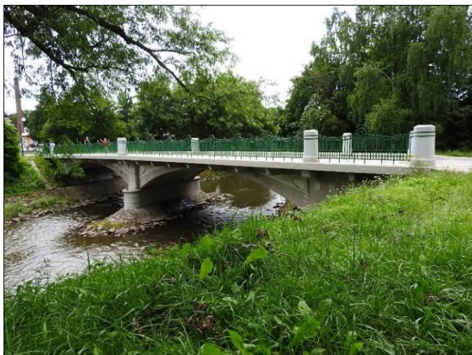
Obr. 78 Vlevo: klenbový most s estetickými prvky; Jihlava – most U Jánů, 1909, L = 16 m. Vpravo: esteticky ztvárněné podélné okraje oblouku a závěsů (vlysy) a esteticky ztvárněná hlavice v místě napojení závěsu na oblouk; Dřevohostice, 1931, L = 19,700 m
