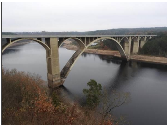
Obr. 75 Vlevo: náhrada části vzpěr nad obloukem menšími oblouky; Podolsko, 1942, L_{max} = 150,000 m. Vpravo: „dvoupatrová“ konstrukce s dolní a s mezilehlou mostovkou současně. Na horní mostovce je pozemní komunikace, na dolní mostovce je potrubí s přívodním kanálem do vodní elektrárny; MVE Popelnice – Tanvald, 1913, L = cca 30 m.
