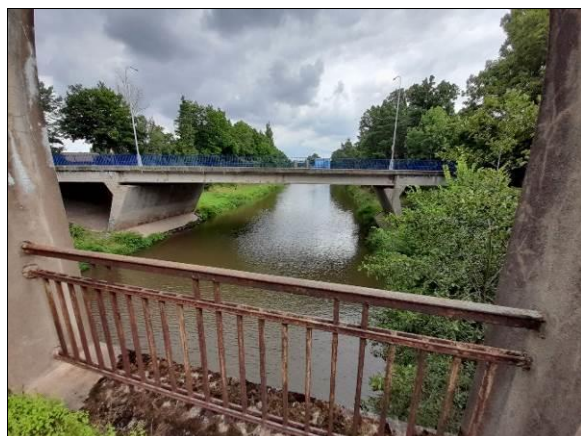
Obr. 84 Výstavba nového souběžného mostu, ponechání původního mostu pro lehkou dopravu. Vlevo: Smiřice, 1933, L = 33,000 m. Vpravo: Sokolov, 1920, L = 34,000 m.
