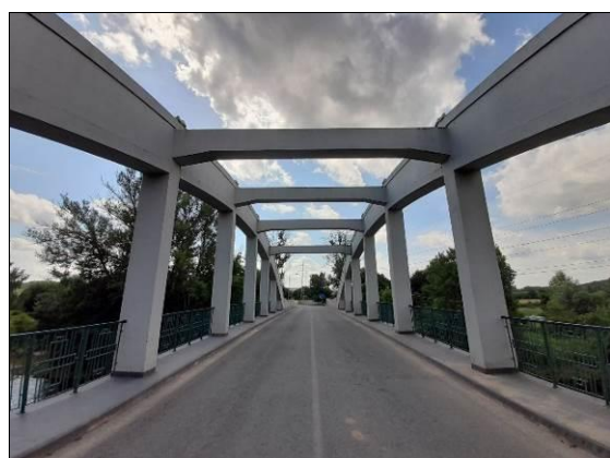
Obr. 60 Oblouk s dolní mostovkou, uložení na ložiska, bez chodníků. Vlevo: pohled na povrch mostu. Vpravo: pohled mostovky (podélná krajní táhla/trámy, mezilehlé podélníky, příčnický v místě závěsů, mostovková deska v jedné úrovni – most bez chodníků). Zálužice, 1934, L = 42,500 m.
