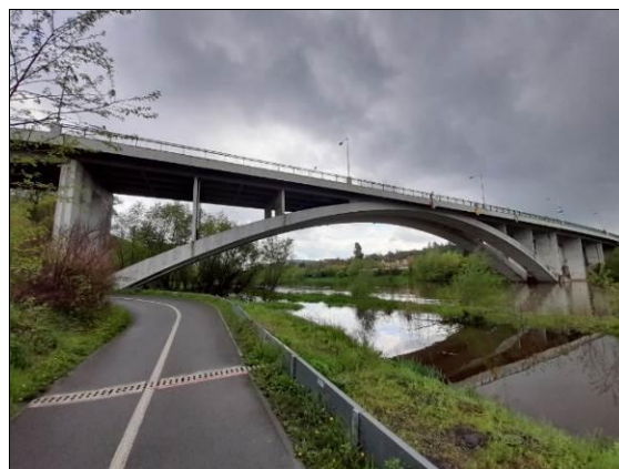
Obr. 23 Vlevo: oblouk s horní mostovkou – oblouk průřezu tvaru \pi ; Oparno, 2010, L = 135,0 m. Vpravo: oblouk s horní mostovkou – oblouk s komorovým průřezem (a rozděleným na dva pasy); Praha – Zbraslav, 1964, L = 86,000 m.
