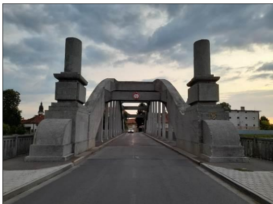
Obr. 77 Vlevo: esteticky ztvárněné ukončení mostu, vetknutý oblouk (mostovka rozdělená příčnou dilatační spárou u opěry); Uherský Ostroh, 1927, L = 52,80 m.
