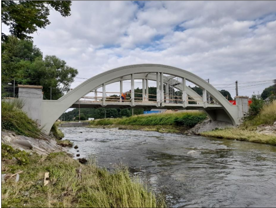
Obr. 47 Vetknutý oblouk s dolní mostovkou, příčná dilatační spára mostovky uprostřed rozpětí, v místě dilatační spáry jsou zdvojené závěsy; Hradec – Nová Ves, L = 30,000 m
