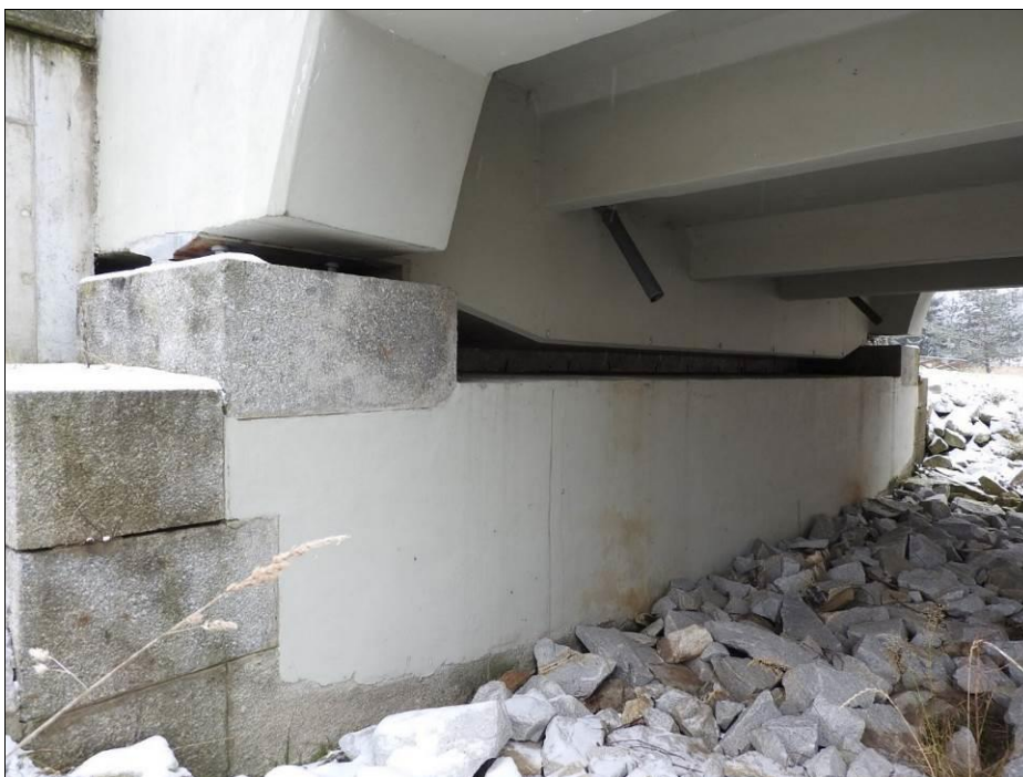
Obr. 38 Oblouk s dolní mostovkou, uložení na ložiska – pevná ocelová ložiska (na druhé opěře je posuvné uložení pomocí válcových ložisek – viz Obr. 39 ); Horní Vltavice, 1926, L = 27,300 m
