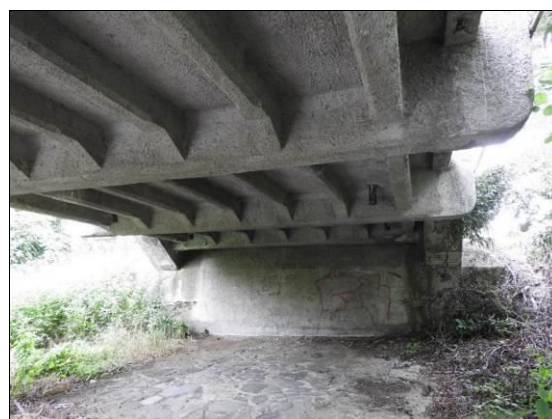
Obr. 59 Dvoukloubový oblouk s dolní mostovkou, bez chodníků. Vlevo: pohled na povrch mostu. Vpravo: pohled mostu – mostovka bez podélných táhel (vodorovná síla z oblouku se přenáší přímo do podpěr); Brantice, 1920, L = 32,000 m
