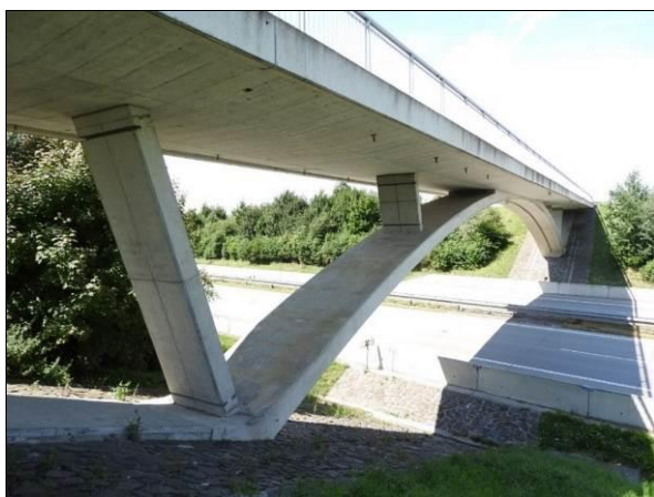
Obr. 76 Vlevo: oblouk s horní mostovkou a se vzpěrami mezi koncem mostovky a patkou oblouku; Klimkovice, 2009, L = 53,700 m.
